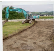
Un décapage dans les règles
