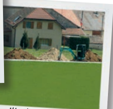
Fouille lors de pose rapide de canalisations
